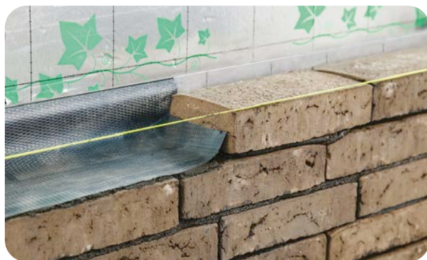
1 Relevé de la membrane de drainage à son extrémité.
