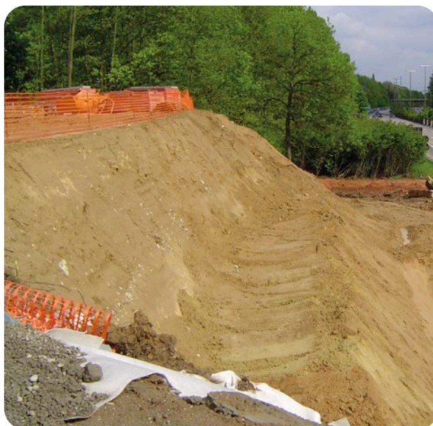
2 Aanleg van een berm in het midden van een talud om de stabiliteit ervan te vergroten en het onderhoud te vergemakkelijken.
