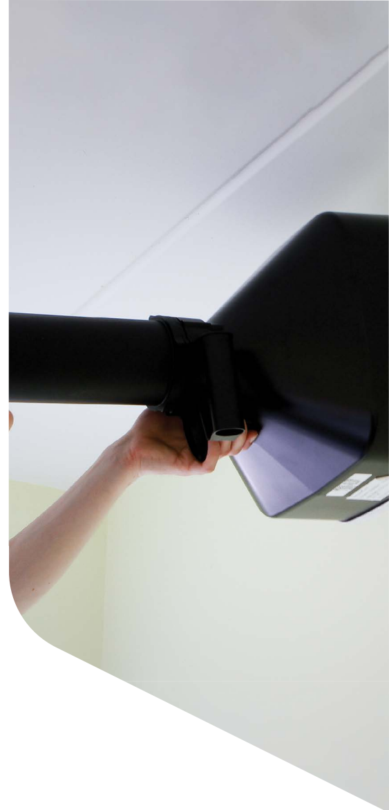
Fig : Mesure des débits de ventilation mécanique au niveau d'une bouche
