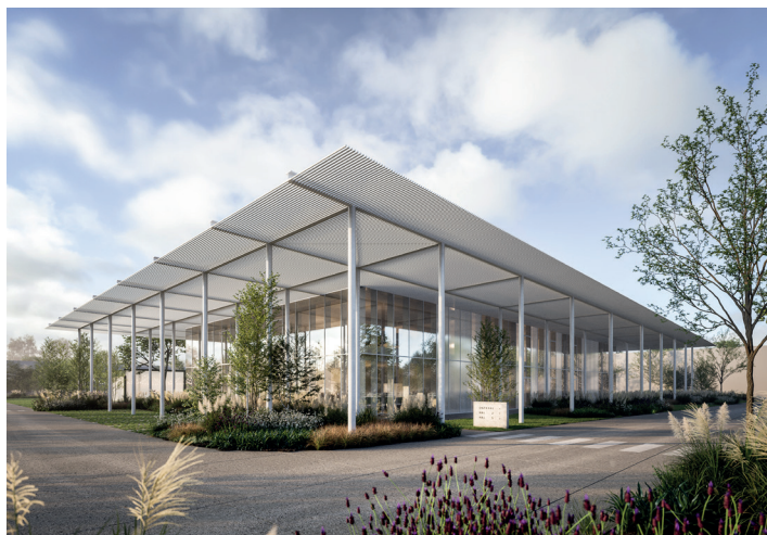
Van Roey Services garantit que le bâtiment et les installations fourniront pendant vingt ans le confort souhaité, sans que la consommation d'énergie n'explose.
