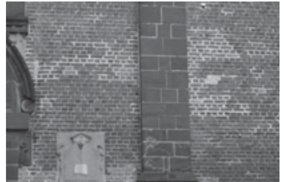
Lors du choix du mortier de rejointoiment, outre les critères techniques, les critères esthétiques ont également un rôle à jouer.
