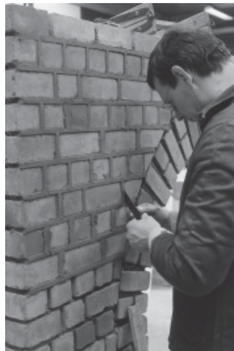
Réalisation des joints coupés.
