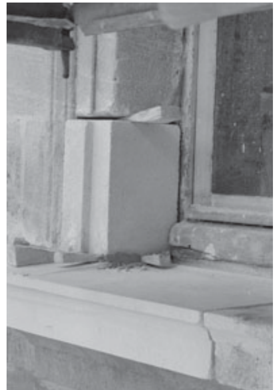
Exemple de remplacement d'une pierre en façade.
