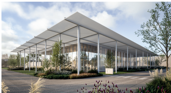
Van Roey Services zorgt dat het gebouw en de installaties gedurende twintig jaar het gewenste comfort leveren, zonder dat het energieverbruik de pan uit swingt.
