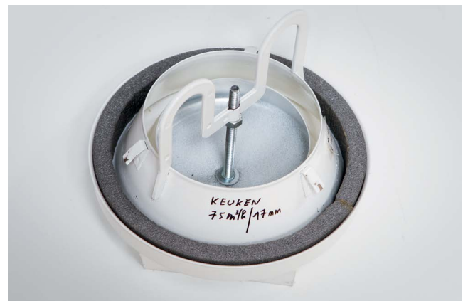
Afb: Geblokkeerd en gemarkeerd ventiel (naam van de ruimte, ontwerpdebiet en afstelpositie)
