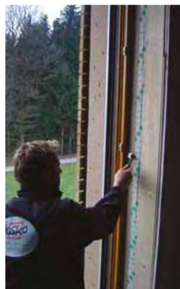
Fig. 49 Étanchéité à l'air et protection contre le vent à Pettenbach (adapté de Lang et al.) [62].
