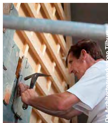
Fig. 91 Fixation sur chantier de la finition extérieure à Roosendaal [76].
