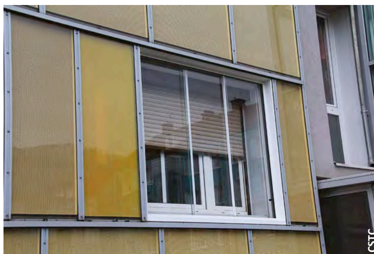
Fig. 46 Conservation de la fenêtre existante et intégration d'une fenêtre étanche à l'air munie de simple vitrage dans un module AIM-ES.
