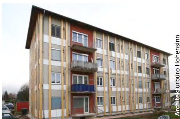
Fig. 37 À gauche : sous-structure d'égalisation horizontale pour modules verticaux à Riihimäki [56]. À droite : sous-structure d'égalisation verticale pour modules horizontaux à Graz [61].
