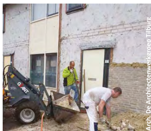
Fig. 81 Démantèlement partiel d'un mur creux à Roosendaal [76].
