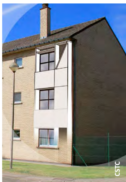
Fig. 1 Éléments de façade rapportés sur un bâtiment existant.
