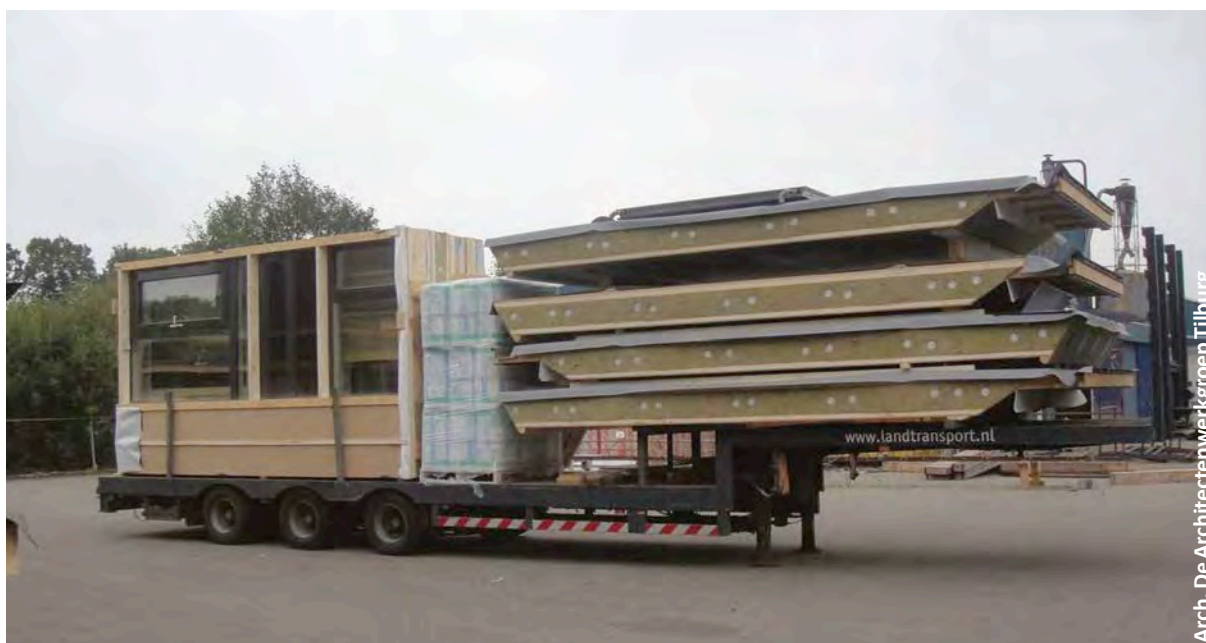
Fig. 85 Chargement des modules en vue de leur livraison sur le chantier à Roosendaal [90].
