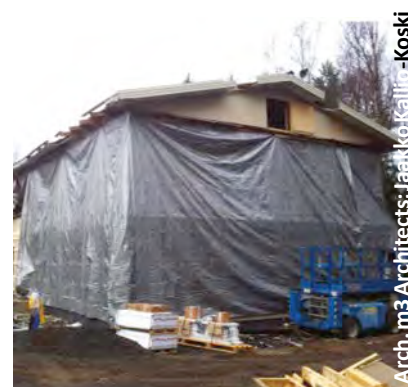
Fig. 84 Protection des modules avant la mise en œuvre du revêtement à Oulu [67].
