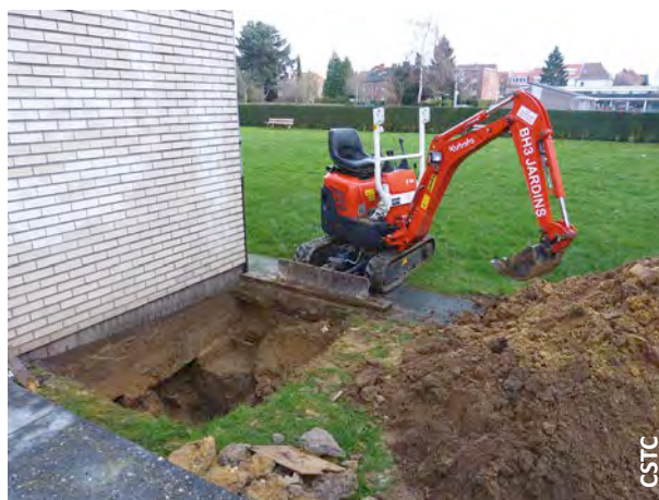
Fig. 20 Excavation effectuée dans le but de décrire le système de fondation.
