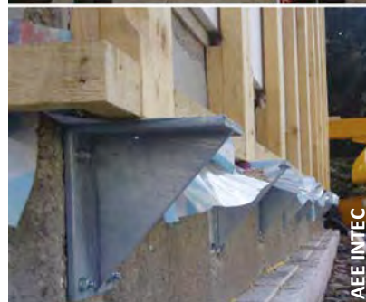
Grandes consoles pour la reprise des charges au pied du bâtiment
