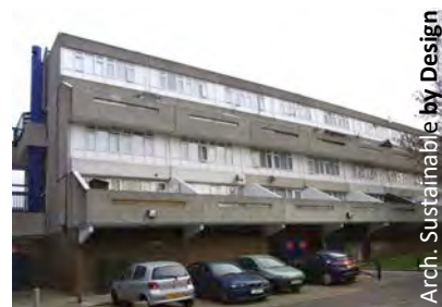
Fig. 9 Appartements à Londres avant rénovation : un immeuble caractérisé par une conception dépassée et des problèmes thermiques.
