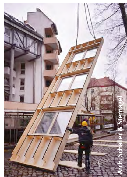
Fig. 6 Rénovation d'un immeuble à appartements, à Berlin, à l'aide d'un système TES ouvert [80].
