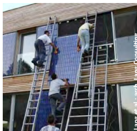
Fig. 93 Installation de panneaux photovoltaïques à Pettenbach [62].
