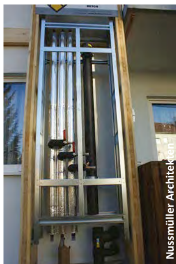
Fig. 56 Conduits de ventilation intégrés dans une gaine, à Kapfenberg (adapté de Nussmüller Architekten).
