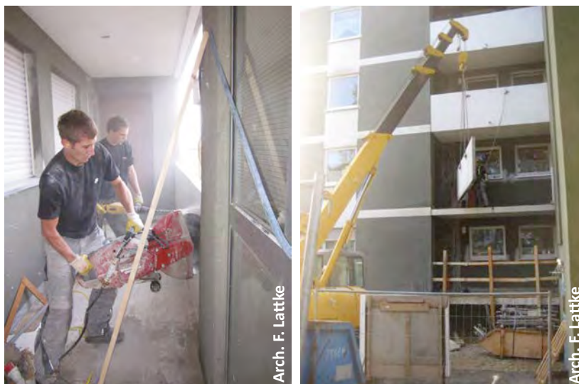
Fig. 79 Découpage d'anciens balcons à Augsburg .
