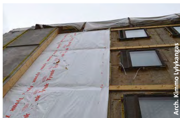
Fig. 37 À gauche : sous-structure d'égalisation horizontale pour modules verticaux à Riihimäki [56]. À droite : sous-structure d'égalisation verticale pour modules horizontaux à Graz [61].
