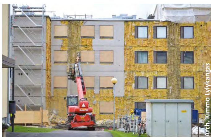
Fig. 80 Démontage partiel des murs sandwiches à Riihimäki [56].
