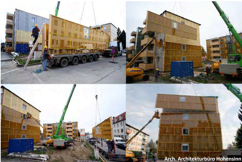
Fig. 89 Processus d'assemblage à Graz .
