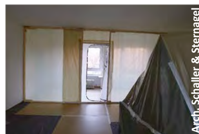
Fig. 78 Écran antipoussière pour la protection des espaces intérieurs pendant les travaux sur chantier (Berlin) [80].
