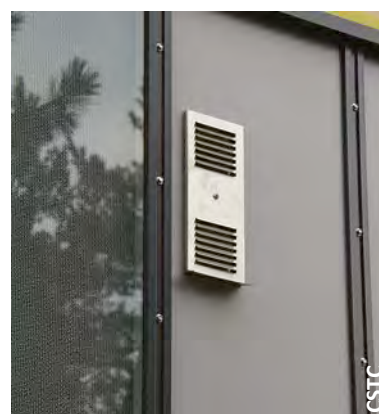
Fig. 52 Technologie de ventilation décentralisée utilisée à Graz .
