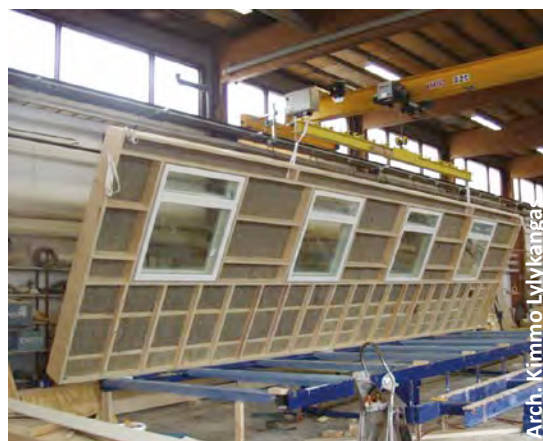
Fig. 35 Structure en bois en couches croisées (Riihimäki) [56].
