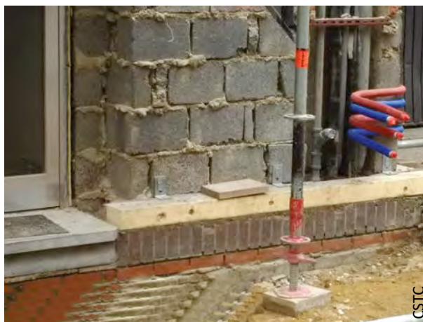
Fig. 82 Mise en œuvre d'une nouvelle fondation dans le cadre d'un projet de rénovation expérimentale Ecoren.
