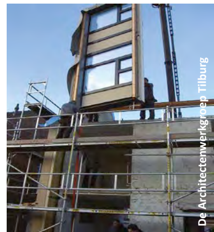
Fig. 5 Rénovation de maisons de rangée, à Roosendaal, à l'aide d'un système TES fermé.
