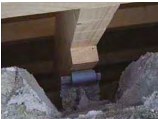
Fig. 72 Système de fixation utilisé à Pettenbach [62].
