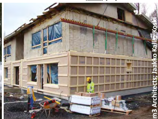
Lames en bois intégrées en usine et revêtement sur chantier (Oulu) [67]
