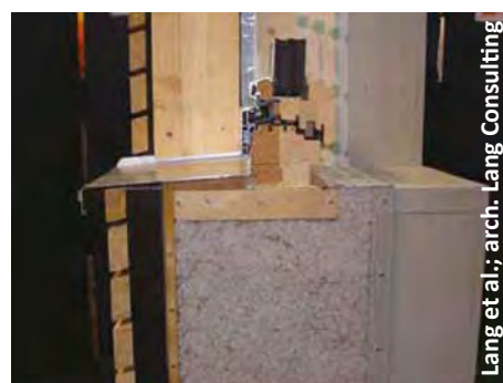
Fig. 39 Prototype illustrant la couche d'adaptation insufflée (Pettenbach) [62].
