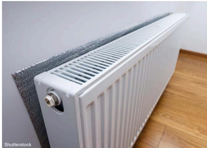
2 | La pose d'un écran réfléchissant derrière un radiateur est une mesure relativement simple pour économiser de l'énergie.
