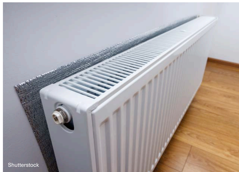
2 | De plaatsing van een reflecterend scherm achter de radiator is een betrekkelijk eenvoudige energiebesparende maatregel.
