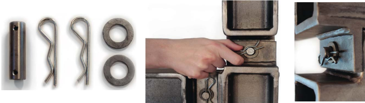
Fig. 25 Assemblage réversible en métal (source : GXN In Building a circular future ) [35].
