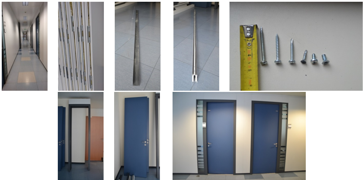
Fig. 33 Démontage de parois modulaires résistant au feu (source : CSTC).
