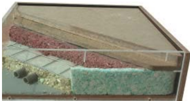
Fig. 47 Maquette du sol d'un local de l'étage : on aperçoit la sous-chape en déchets de polyuréthane, la chape en déchets de polyuréthane et de ciment ainsi que le revêtement constitué de deux panneaux de dureté différente, à base de déchets de bois.
