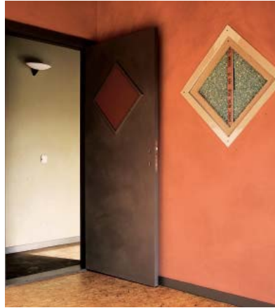
Fig. 48 Vue éclatée dans une cloison d'une pièce de l'étage, révélant l'isolation en polyéthylène recyclé, un panneau à base de cellulose recyclée et de paille recouvert d'une plaque en sulfogypse peinte. Le sol est en panneaux de déchets de bois.
