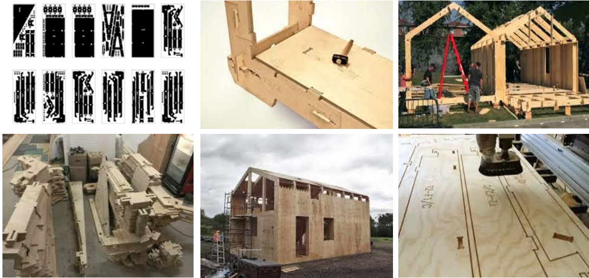
Fig. 55 Réalisation de bâtiments préfabriqués sur la base de plans en accès libre (source : Google - WikiHouse) [162].
