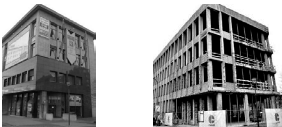
Fig. 31 Maintien de la structure en béton d'un bâtiment en rénovation (source : SWECO, ex-Grontmij, Arteum Architects) [102].
