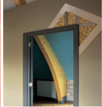
Fig. 49 Cloisons de l'étage : à l'avant-plan, panneaux à base de sulfogypse et de phosphogypse recouverts d'un isolant en mousse de polyéthylène recyclée, cloison du fond en panneaux de gypse avec papier recyclé.
