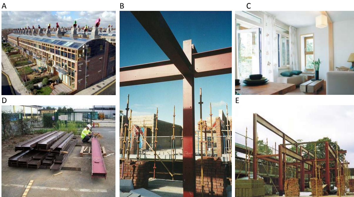
Fig. 46 Constructions réalisées à partir d'éléments et de matériaux récupérés et recyclés (source : ZEDFactory & BioRegional) [108].
