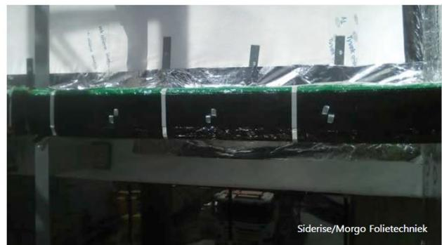
Figure 38 – Application d'une bande intumescente dans une façade ventilée.
