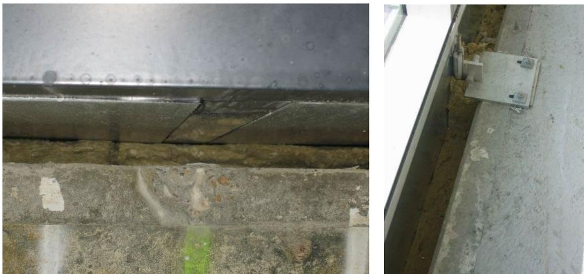
Figure 31 – Resserrage EI 60 à la laine de roche entre le nez de dalle et l'élément de façade étanche au feu (photo de gauche : SRI Louvain; photo de droite : SECO).
