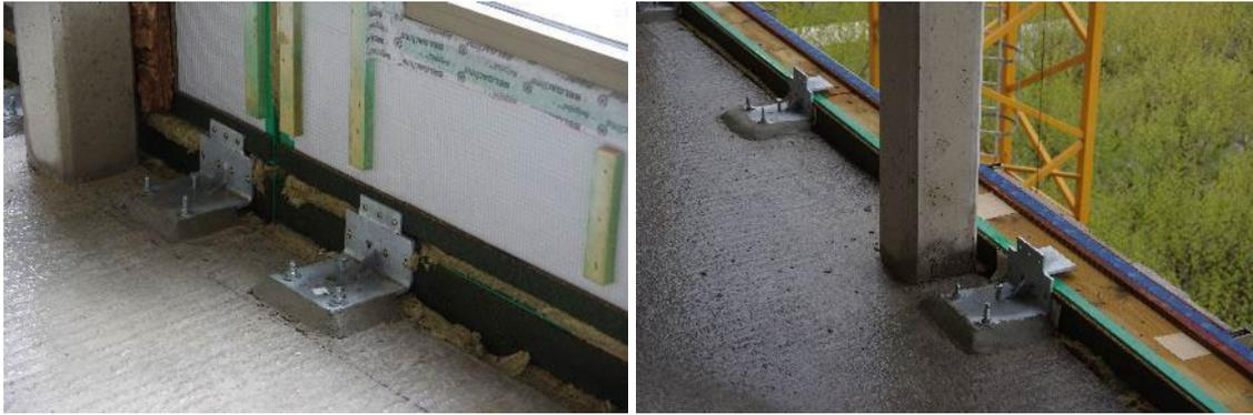
Figure 33 – Élément de façade E 60 à ossature en bois, fixation R 60 sur la dalle et resserrage EI 60 avec le nez de dalle. À gauche : modules inférieur et supérieur placés; à droite : module inférieur placé (photos CSTC – chantier URBICOON, Anvers – MBS).
