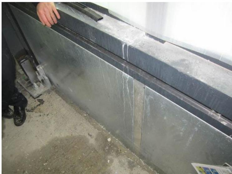
Figure 30 – Élément de façade E 60 constitué de tôles intérieures en acier (SRI Louvain).
