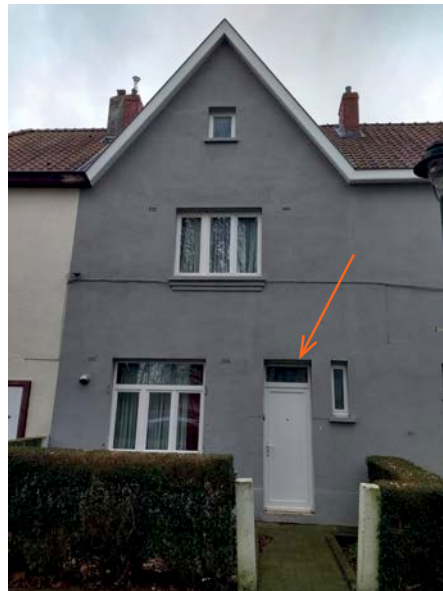
Fig. 20 Emplacement de l'ouverture d'alimentation dans une petite maison (photo d'une maison du Foyer anderlechtois dans le quartier du Bon Air à Anderlecht).
