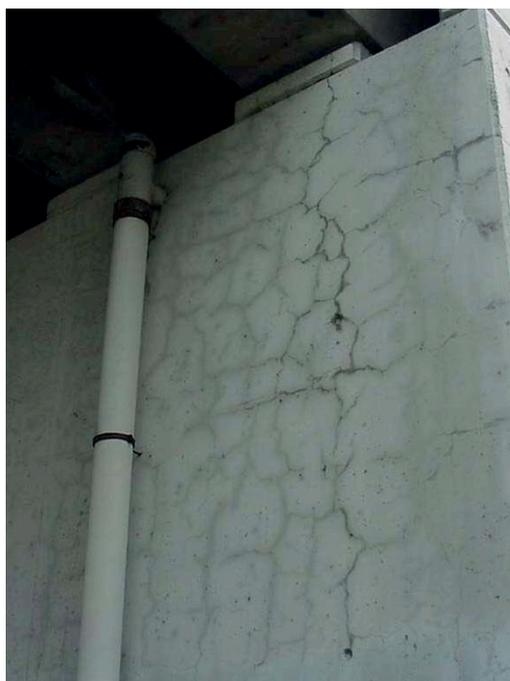
**Fig. 3** Structure en béton touchée par une réaction alcali-silice.
