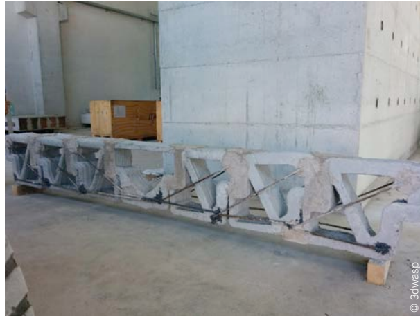
Fig. 30 Poutre renforcée par assemblage d'armatures externes.
