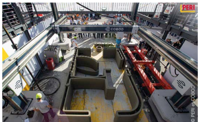
Fig. 35 Impression en 3D des murs d'une petite maison, à l'extérieur, lors de l'exposition Bauma en Allemagne.
