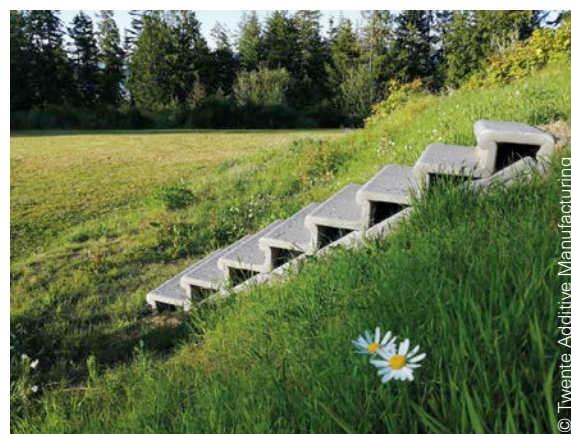
Fig. 61 Escalier imprimé en mortier.
