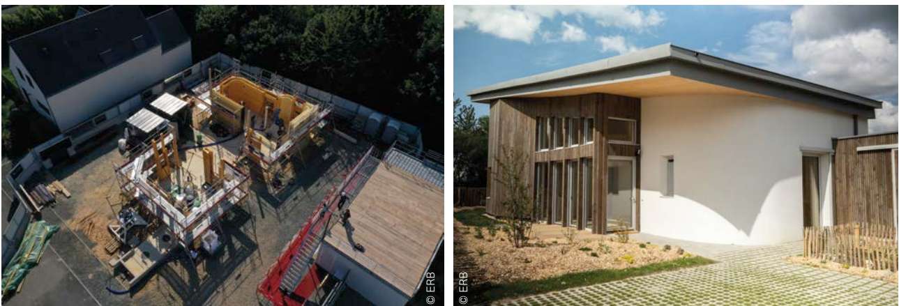
Fig. 20 Deux parois en mousse de polyuréthane imprimées en 3D entre lesquelles du béton est coulé (gauche) et maison 'Empreinte' (droite).
