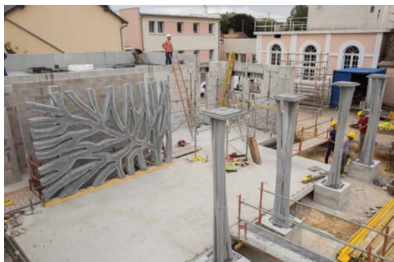
Fig. 49 Moules des poteaux extérieurs imprimés en 3D.
