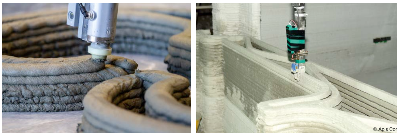
Fig. 33 Surface latérale en strates (gauche) et talochage de la surface par des truelles latérales (droite).
