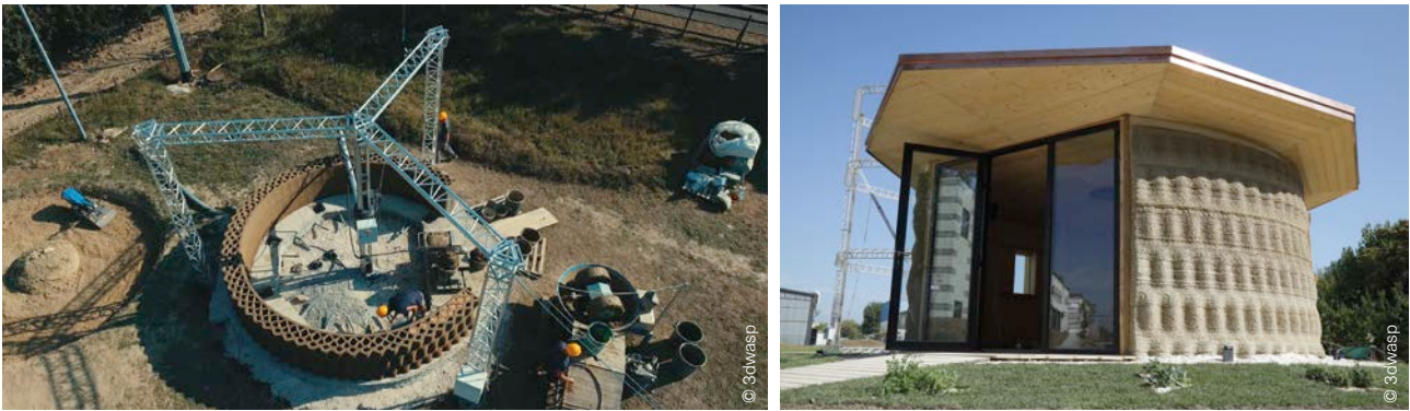
Fig. 16 Maison Gaïa imprimée par la Crane WASP.
