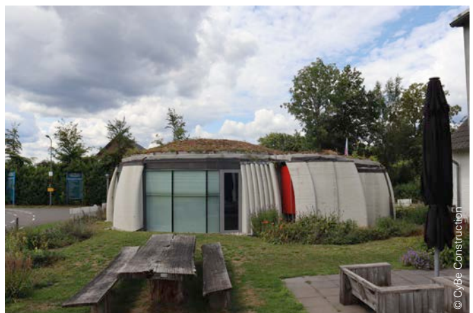
Fig. 43c Imprimante CyBe RT (Robot Track) et exemple d'une structure imprimée aux Pays-Bas par le robot CyBe RC – https://cybe.eu/ .
