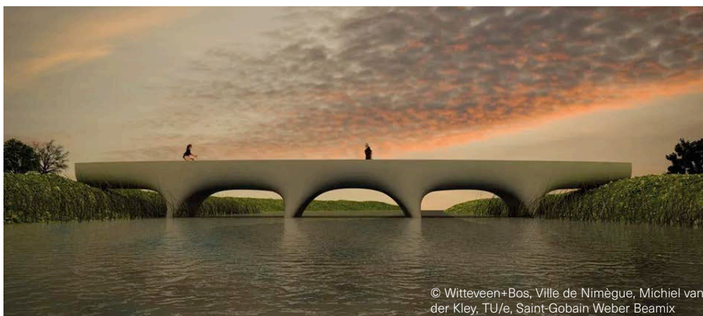
Fig. 59 Passerelle de Nimègue (Pays-Bas) imprimée en 3D.
