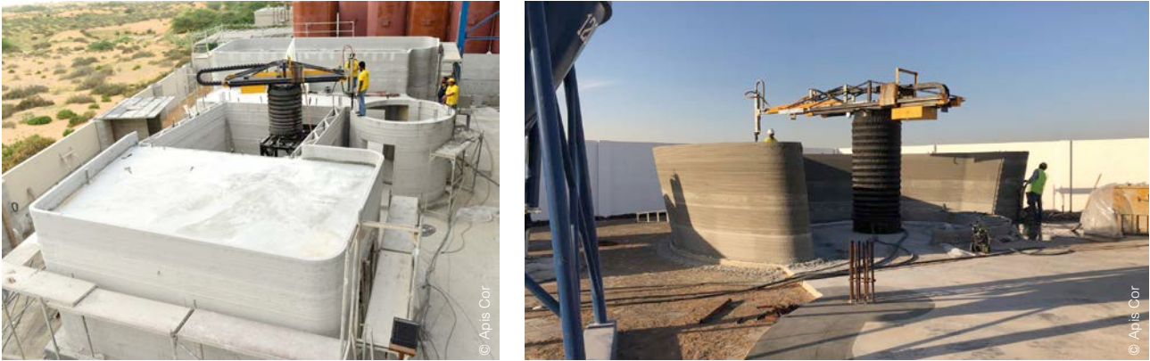
Fig. 47 Imprimante Frank développée par Apis Cor.
