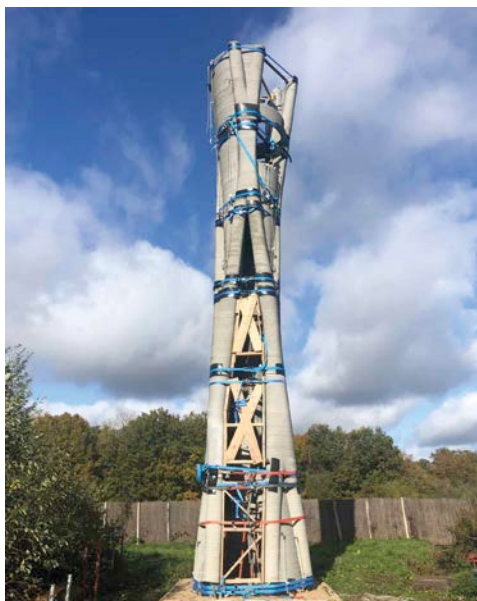
Fig. 48 Pylône de 12 mètres réalisé par impression et assemblage de six coffrages de voussoirs.
