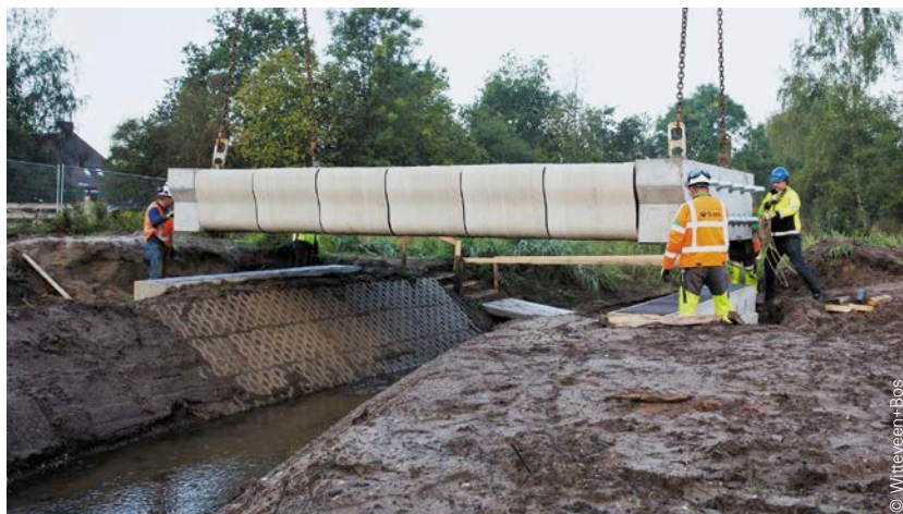
Fig. 31 Pont en mortier imprimé en 3D à Gemert (Pays-Bas).
