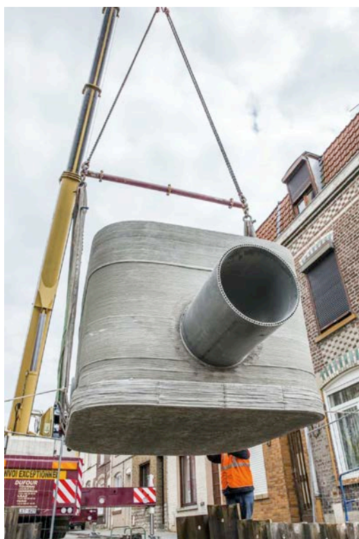
Fig. 50 Déversoir d'orage installé à La Madeleine à Lille (France).
