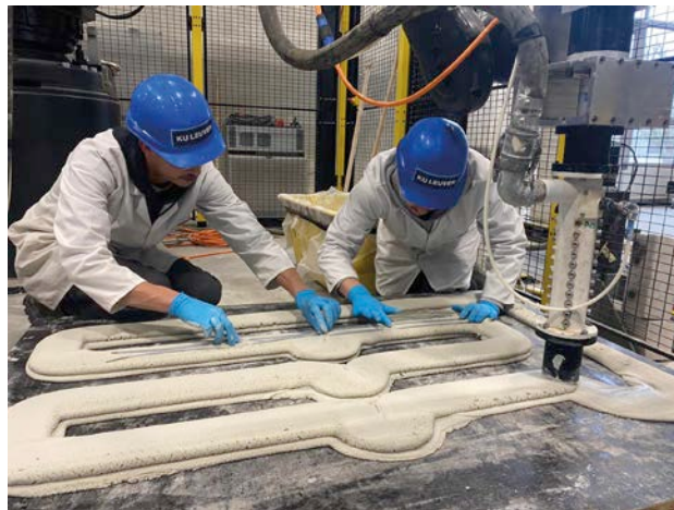
Fig. 22 Ajout manuel de renforcement entre les couches imprimées (pièce imprimée chez Buildwise en collaboration avec la KU Leuven).
