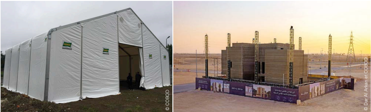
Fig. 34 Projets de construction 3D réalisés par les imprimantes COBOD. Bureau imprimé sous tente au Danemark (gauche) et villa de trois étages imprimée en 3D dans une zone non couverte en Arabie Saoudite (droite).
