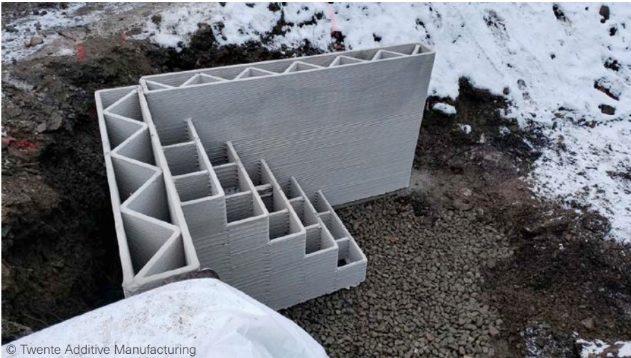
Fig. 58 Murs de soutènement imprimés en 3D.
