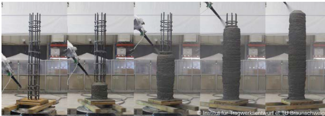
Fig. 29 Étapes de construction d'une colonne renforcée par la méthode SC3DP.
