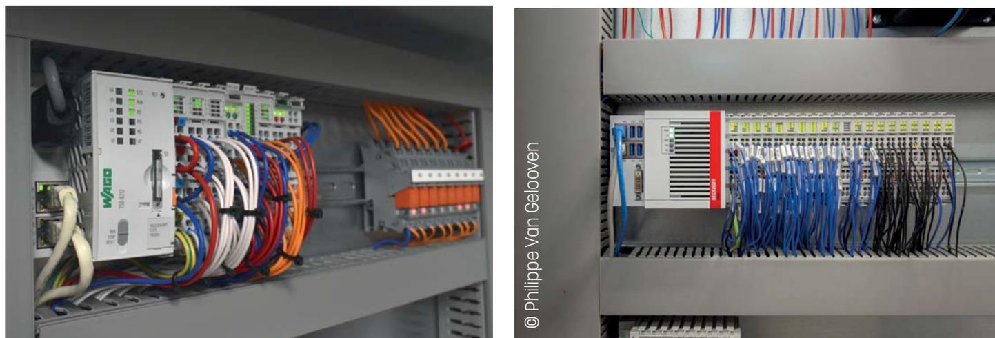
Fig. 18 Exemples de systèmes de gestion des bâtiments utilisant un PLC (*programmable logic controller*).
