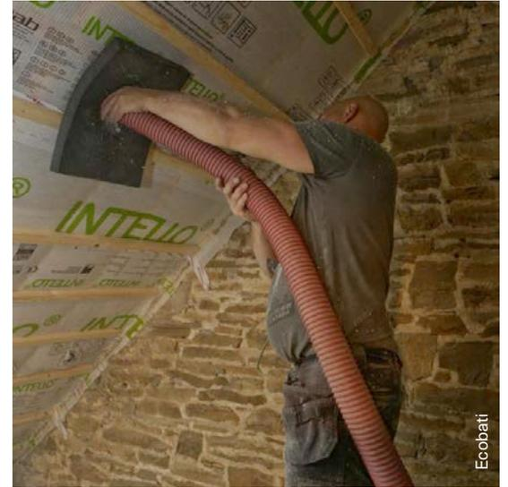
**Fig. 7** Rénovation de la toiture d'un ancien bâtiment par insufflation de ouate de cellulose.
