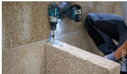
Fig. 7 Fixation au moyen d'une équerre et d'une vis.
