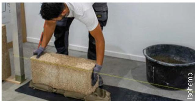
Fig. 1 Pose du premier rang sur une membrane.
