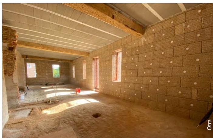
**Fig. 2** Isolation d'une toiture au moyen de fibres d'herbe et de murs au moyen de blocs de chaux-chaux dans un chantier en Wallonie.
