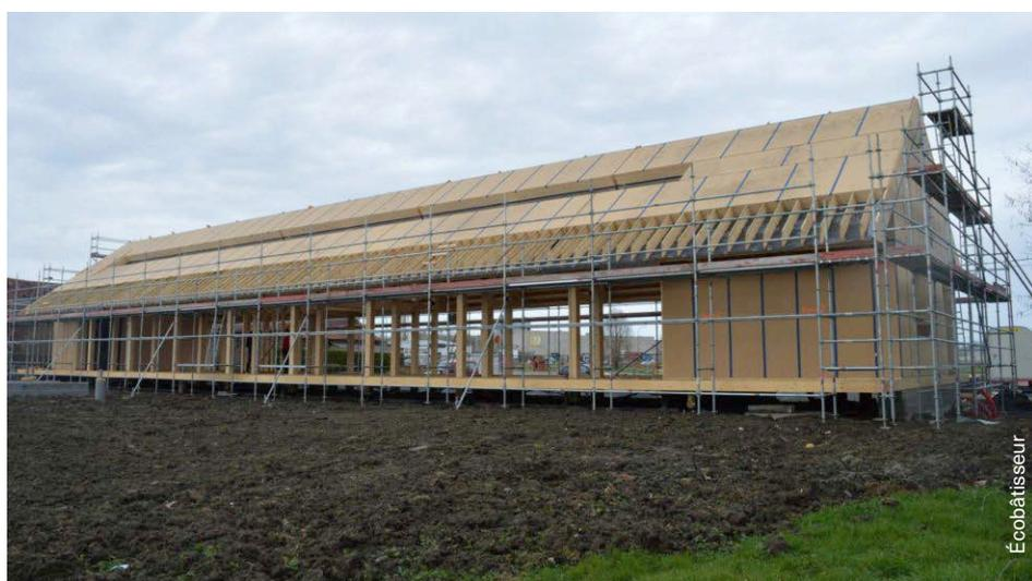
**Fig. 5** Édifice bâti selon le principe de l'écoconstruction (restaurant-salle de sport) à Mouscron à partir d'une ossature en bois et d'une isolation sous forme de paille.
