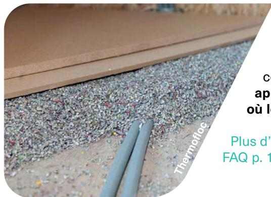
Les granulés de cellulose sont obtenus par compression de fibres de cellulose. Ils sont mis en œuvre par **épannage**. L'isolation en vrac permet un remplissage complet des compartiments dans les endroits difficilement accessibles. **Une application en compression (chape sèche) est déconseillée dans une pièce où le tassement pourrait poser problème.**
