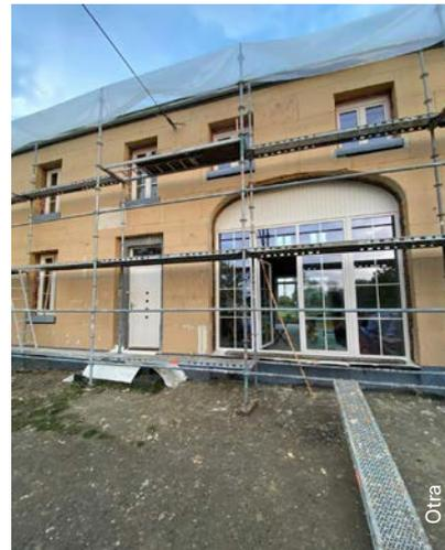
**Fig. 8** Rénovation de façades à l'aide d'un isolant en fibres de bois rigide et d'un enduit.
