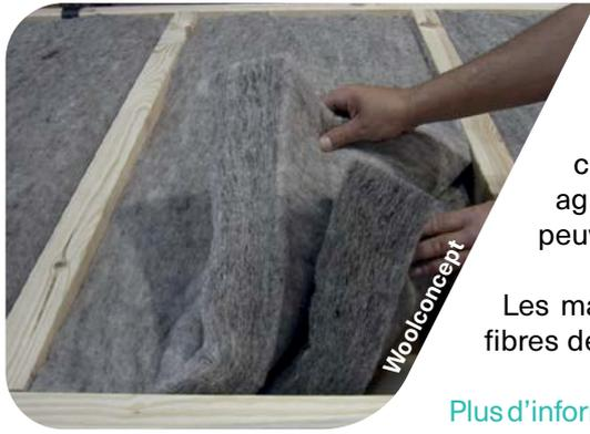
Les matelas en laine de mouton servent d'isolation entre ossatures dans de multiples applications. Ils s'adaptent bien aux irrégularités et peuvent être utilisés tant en rénovation qu'en construction neuve. Ils se posent simplement comme les autres laines du marché. Pour assurer une bonne tenue, on peutagrafer l'isolant aux montants. Seuls les matelas provenant de fabricants officiels peuvent être employés (laine prétraitée).
