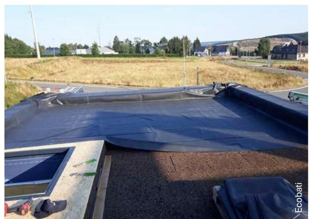
**Fig. 9** Toiture plate comportant des panneaux isolants en liège.
