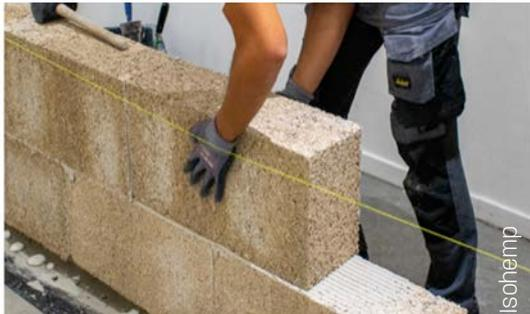
Fig. 3 Pose des rangs suivants.
