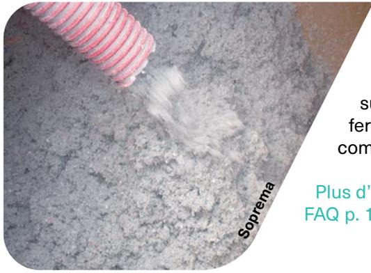
L'ouate de cellulose est obtenue par recyclage de papier journal. Celui-ci est broyé, défilé puis malaxé et traité. L'ouate est mise en œuvre par **soufflage** sur surfaces horizontales (planchers, combles), par **insufflation** dans des cavités fermées ou par **projection** humide. L'isolation en vrac permet un remplissage complet des compartiments dans les endroits difficilement accessibles.
