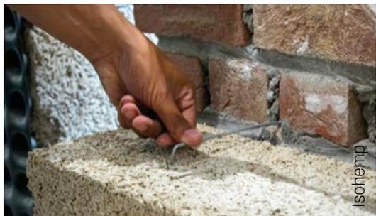
Fig. 6 Fixation au moyen d'un crochet.
