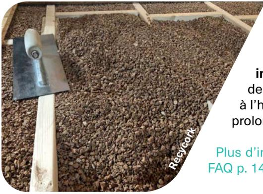
Le liège expansé provient de l'écorce du chêne-liège. L'écorce est réduite en granules puis expansée à la vapeur d'eau. Le liège est mis en œuvre par **insufflation** ou par **épannage**. L'isolation en vrac permet un remplissage complet des compartiments dans les endroits difficilement accessibles. Bien que résistant à l'humidité, le liège est un matériau biosourcé et ne doit pas rester en condition prolongée d'humidité extrême.
