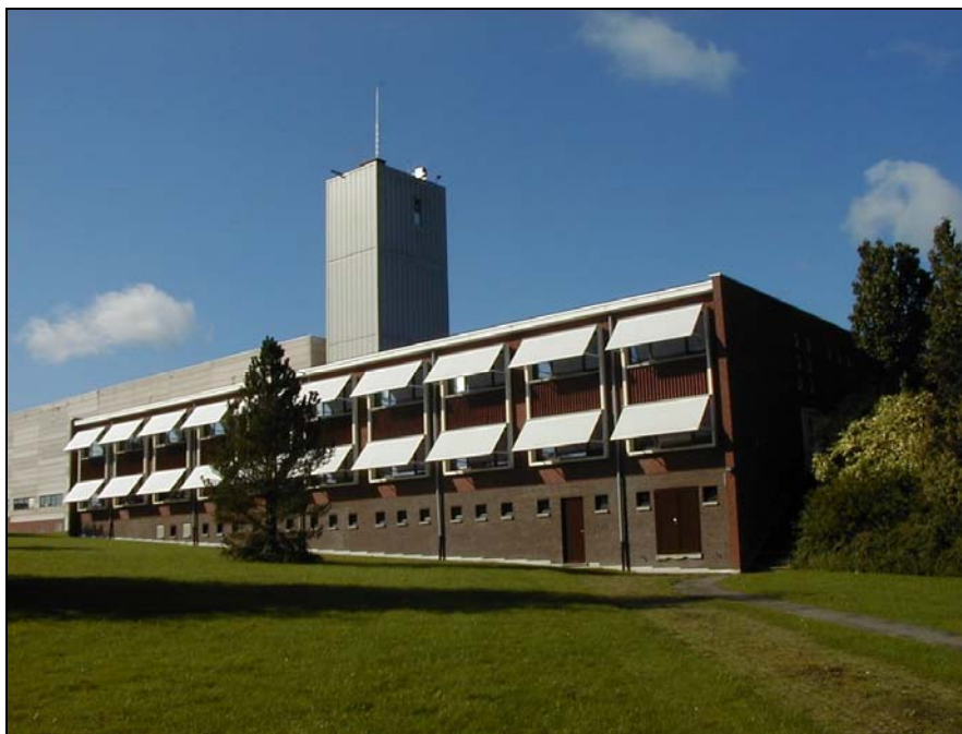
Figure 13 : Vue du bâtiment PROBE
