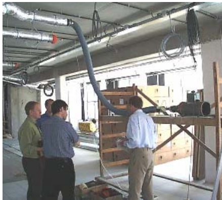
Figure 7 : Pressurisation d'un conduit de ventilation
