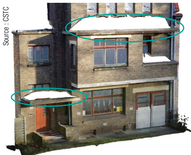
Fig. 34 Inconvénient de la photogrammétrie à partir d'images prises au sol : les zones non visibles sur les photos (toitures, balcons, par exemple) donnent des 'trous' dans les modèles 3D reconstruits.
