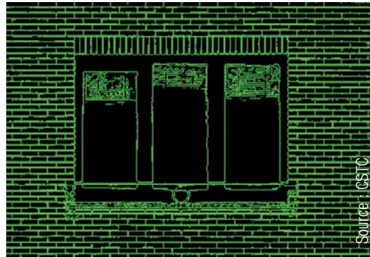
Fig. 23 Traitement numérique appliqué à une photographie de façade afin de mettre en évidence les joints de la maçonnerie.
