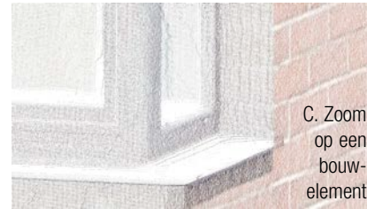
Afb. 2 Puntenwolk verkregen door middel van een opmeting met een laserscanner (bron van de afbeeldingen: WTCB / bron van het model: De Ceuster).
