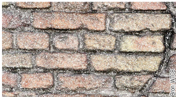
Afb. 1 Door opmeting in hoge resolutie kunnen fijne details in gebouwen opgevangen worden (in dit geval metselwerk).
