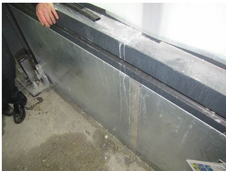
Afbeelding 30 – Vlamdicht gevelement E 60 opgebouwd uit inwendige staalplaten (Brandweer Leuven).
