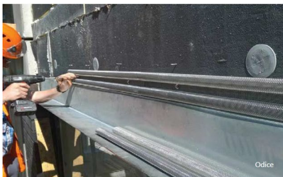
Afbeelding 38 – Toepassing van een opzwellende strook in een geventileerde gevel.
