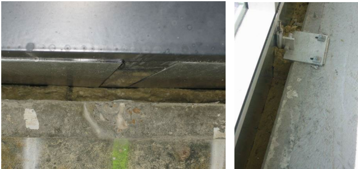
Afbeelding 31 – Brandwerende afdichting EI 60 met rotswol tussen de zijkant van de vloerplaat en het vlamdichte gevelement (linkerfoto: Brandweer Leuven; rechterfoto: SECO).
