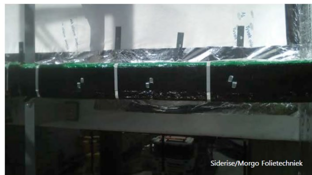
Afbeelding 38 – Toepassing van een opzwellende strook in een geventileerde gevel.
