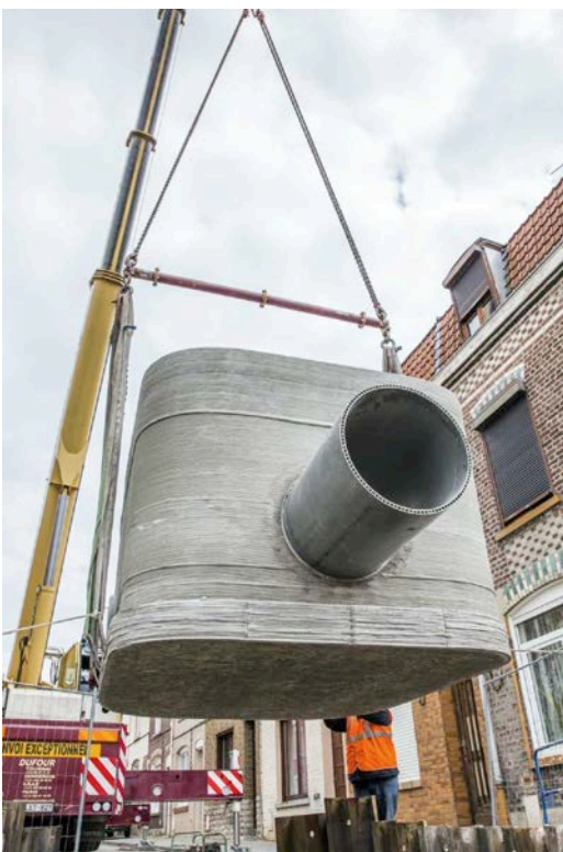
Afb. 50 Stormoverloop die geïnstalleerd werd bij La Madeleine in Lille (Frankrijk).
