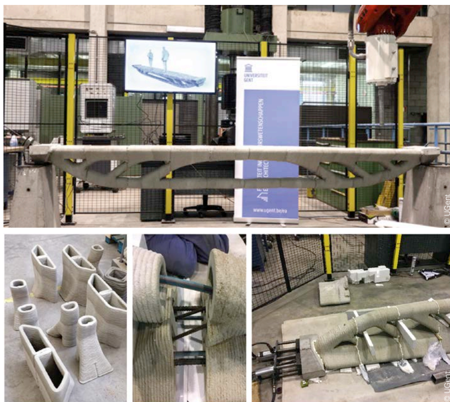
Afb. 32 Stappen van de wapening met behulp van voorspankabels van een 3D-geprinte brug.
