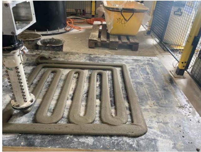
Afb. 18 Printen van een mortel op basis van gerecycleerd Belgisch zand, aangeleverd door het recyclegecentreum voor inert afval RECYMEX (proef uitgevoerd bij Buildwise in samenwerking met de Universiteit van Luik).
