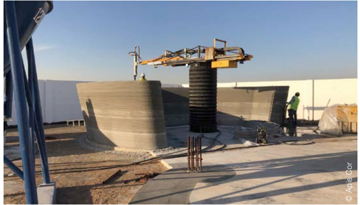
Afb. 47 De printer Frank die ontwikkeld werd door Apis Cor.
