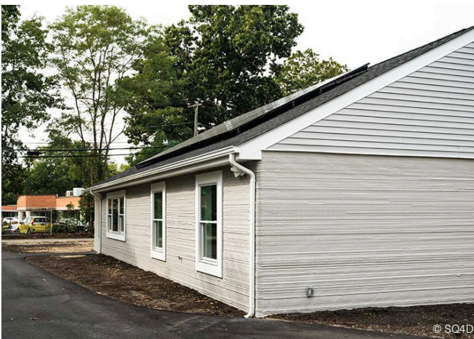
Afb. 13 Het huis dat 3D-geprint werd door de firma SQ4D.
