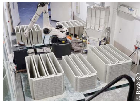
Afb. 55 3D-geprinte gevel uit mortel.
