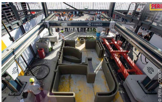
Afb. 35 3D-printen van de muren van een kleine woning in buitenomstandigheden, tijdens de Bauma-beurs in Duitsland.
