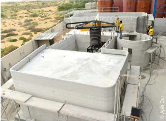
Afb. 47 De printer Frank die ontwikkeld werd door Apis Cor.
