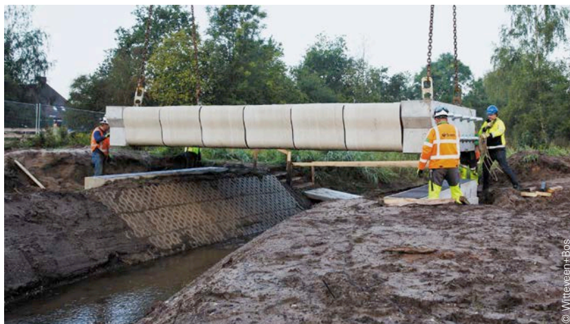
Afb. 31 Brug uit 3D-geprinte mortel in Gemert (Nederland).
