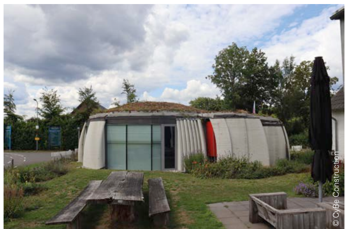
Afb. 43c De printer CyBe RT (Robot Track) en voorbeeld van een constructie die in Nederland geprint werd door de robot CyBe RC – https://cybe.eu/ .
