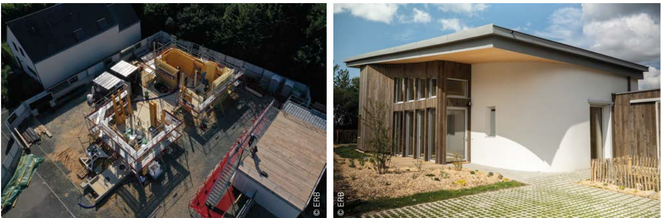
Afb. 20 Twee 3D-geprinte wanden uit polyurethaanschuim waartussen het beton gestort wordt (links) en de woning Empreinte (rechts).
