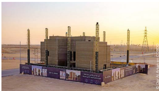
Afb. 34 3D-bouwprojecten, uitgevoerd met COBOD-printers. Onder een tent geprint kantoor in Denemarken (links) en 3D-geprinte villa met drie verdiepingen in een niet-overdekte zone in Saoedi-Arabië (rechts).
