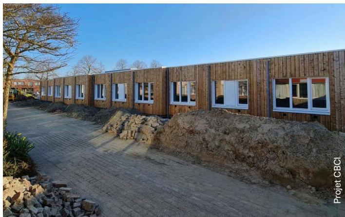
Afb. 1 Renovatie van het ziekenhuiscentrum Emergis-Bouwbedrijf Meliskerke bv (Kloetinge, NL) in houtskeletbouw met behulp van isolatiematerialen in houtvezel. Het ziekenhuiscentrum bevindt zich in het Nederlandse dorp Kloetinge.
