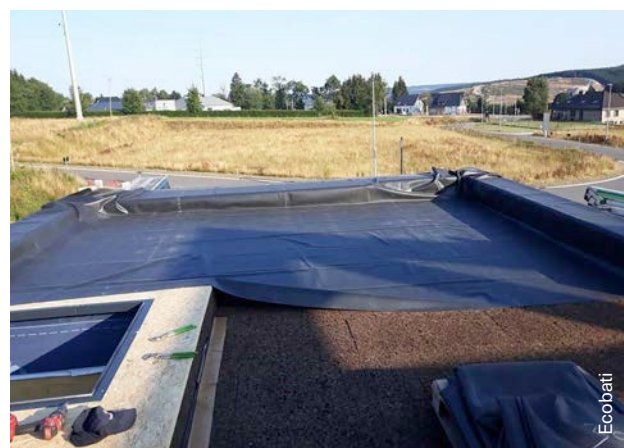
Afb. 9 Plat dak dat bestaat uit isolatieplaten in kurk.
