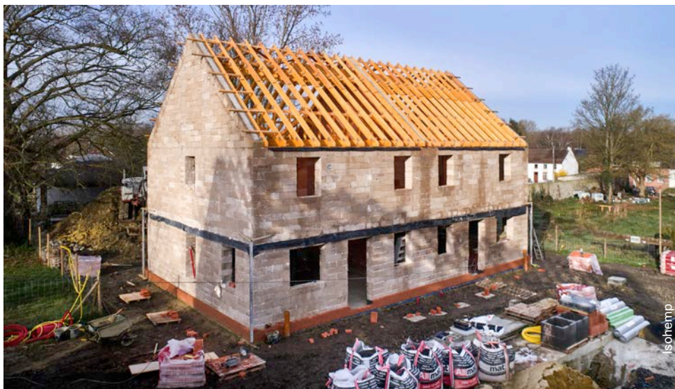
Afb. 4 Nieuwbouw geïsoleerd met kalkhennepblokken.
