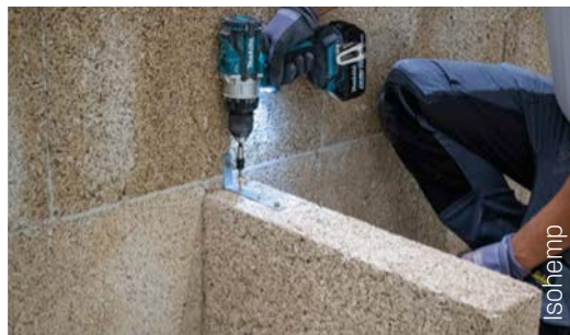
Afb. 7 Bevestiging met verbindingshaak en schroef.
