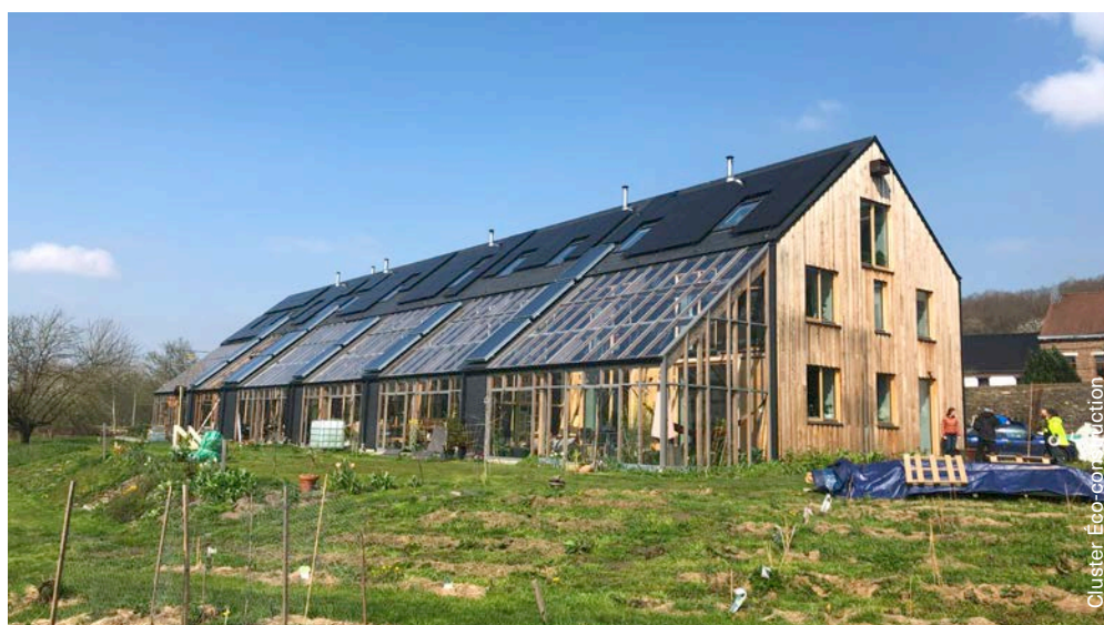
Afb. 6 Gebouwen opgetrokken volgens het principe van ecologisch bouwen (rijhuizen) in houtskeletbouw en geïsoleerd met biogebaseerde isolatiematerialen (houtvezel).
