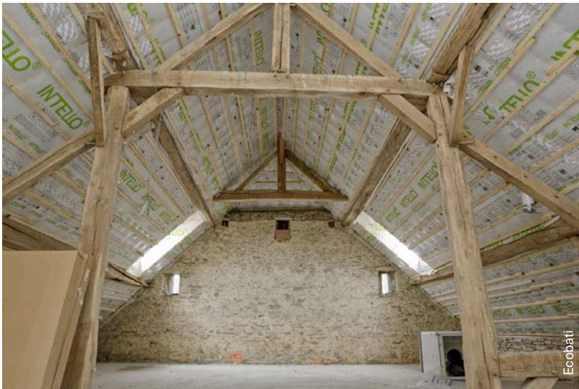
Afb. 7 Dakrenovatie van oud gebouw door inblazen van cellulosewatten.
