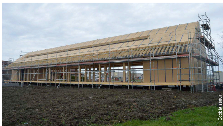
Afb. 5 Gebouw opgetrokken volgens het principe van ecologisch bouwen (restaurant-sporthal) in Moeskroen, in houtskeletbouw en geïsoleerd met stro.
