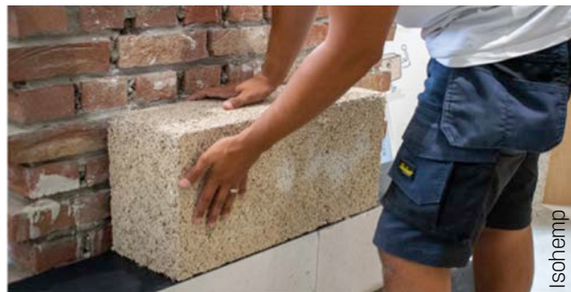
Afb. 2 Plaatsing van de eerste laag op een muurvoet.
