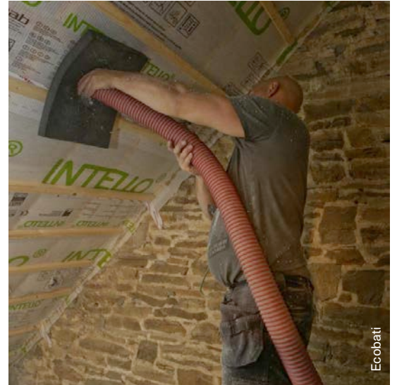
Afb. 7 Dakrenovatie van oud gebouw door inblazen van cellulosewatten.
