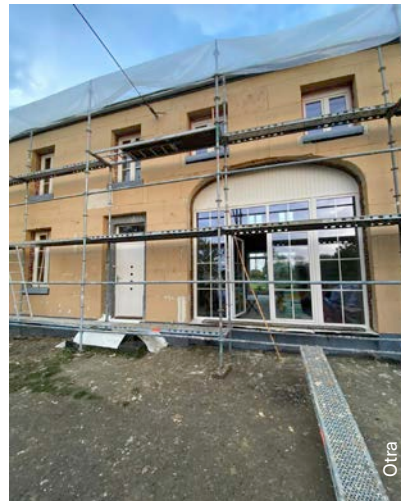
Afb. 8 Gevelrenovatie met isolatiemateriaal in harde houtvezels en bepleistering.
