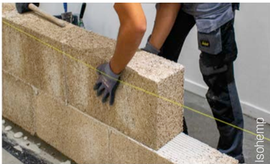
Afb. 3 Plaatsing van de volgende lagen.
