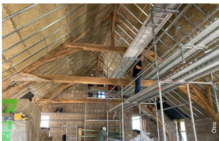
Afb. 2 Voor deze werf in Wallonië werd het dak geïsoleerd met grasvezels. Voor de muren werden kalkhennepblokken gebruikt.
