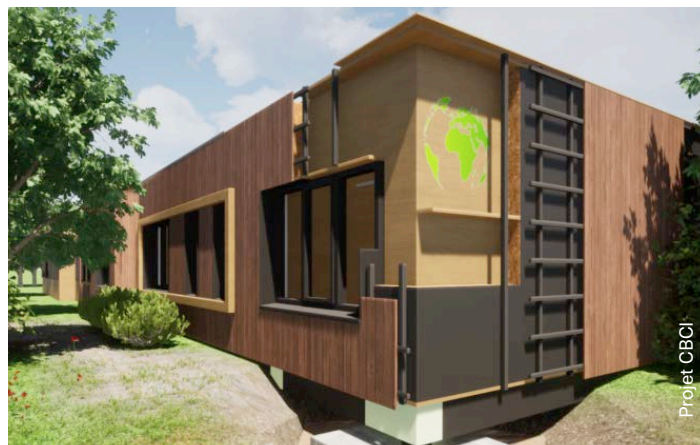
Afb. 1 Renovatie van het ziekenhuiscentrum Emergis-Bouwbedrijf Meliskerke bv (Kloetinge, NL) in houtskeletbouw met behulp van isolatiematerialen in houtvezel. Het ziekenhuiscentrum bevindt zich in het Nederlandse dorp Kloetinge.
