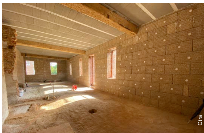
Afb. 2 Voor deze werf in Wallonië werd het dak geïsoleerd met grasvezels. Voor de muren werden kalkhennepblokken gebruikt.
