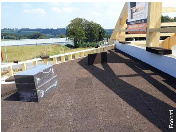
Afb. 9 Plat dak dat bestaat uit isolatieplaten in kurk.
