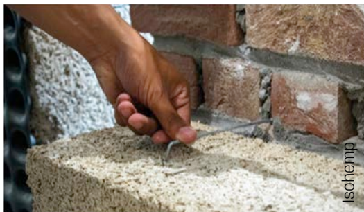
Afb. 6 Bevestiging met spouwhaak.
