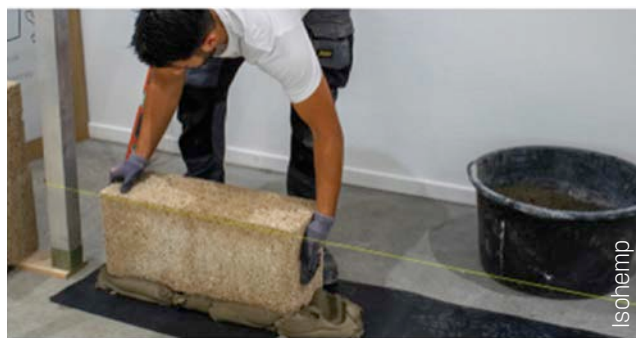
Afb. 1 Plaatsing van de eerste laag op een membraan.
