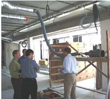
Afb. 7 Pressurisatie van een ventilatiekanaal.
