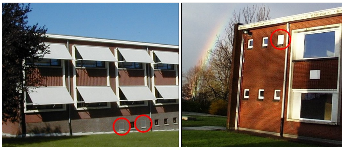
Afb. 31 Luchttoevoer- en luchtafvoeropeningen in het PROBE-gebouw
