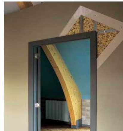
Afb. 49 Scheidingswanden op de verdieping: vooraan, sulfogips- en fosfogipsplaten, bedekt met een isolatiemateriaal uit gerecycleerd polyethyleenschuim; de scheidingswand achteraan bestaat uit gipsplaten met gerecycleerd papier.
