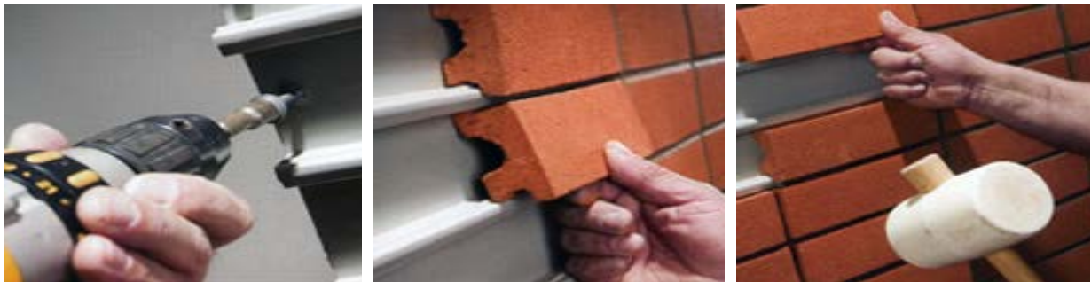
Afb. 15 Demonteerbaar gevelsysteem (bron: Corium en OVAM) [52, 115].
