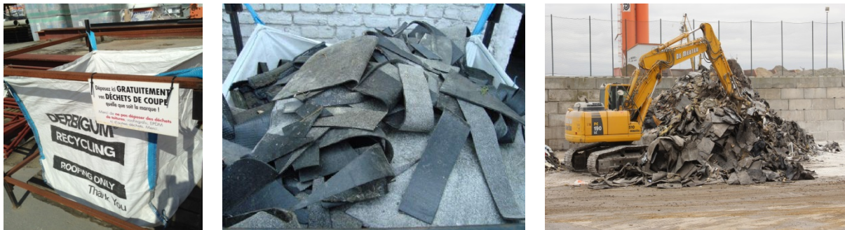
Afb. 60 Recuperatie en inzameling van bitumineuze afdichtingen (bron: Derbigum & WTCB) [119].
