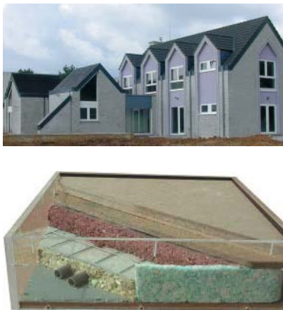
Afb. 47 Maquette van de vloer van een kamer op de verdieping: men ziet er de ondervloer uit polyurethaanafval, de dekvloer uit polyurethaan- en cementafval, alsook de bedekking bestaande uit twee platen op basis van houtafval met een verschillende hardheid.
