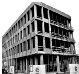
Afb. 31 Behoud van de betonstructuur van een gebouw bij renovatie (bron: SWECO, ex-Grontmij, Arteum Architects) [102].
