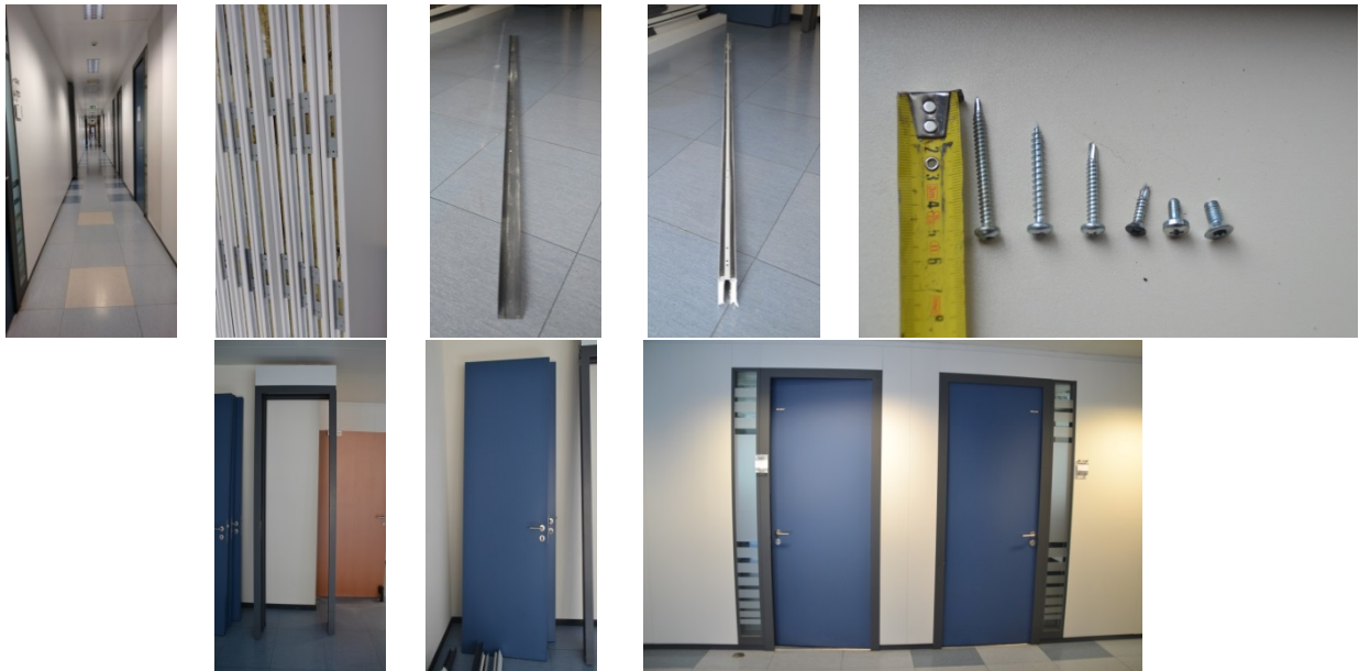
Afb. 33 Ontmanteling van modulaire brandwerende wanden (bron: WTCB).
