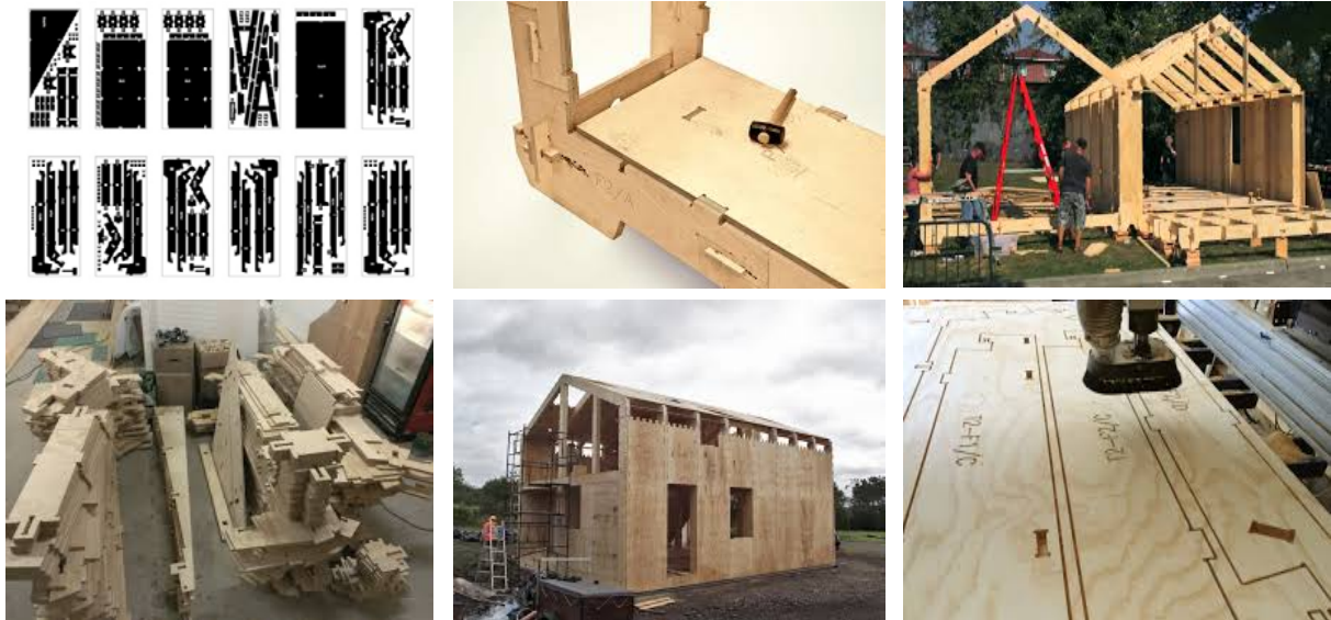
Afb. 55 Uitvoering van geprefabriceerde gebouwen op basis van plannen die vrij toegankelijk zijn (bron: Google - WikiHouse) [162].
