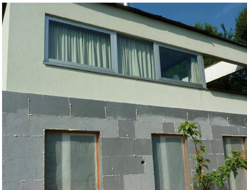
1 | Rénovation énergétique par application d'un nouvel ETICS sur un ETICS existant.
