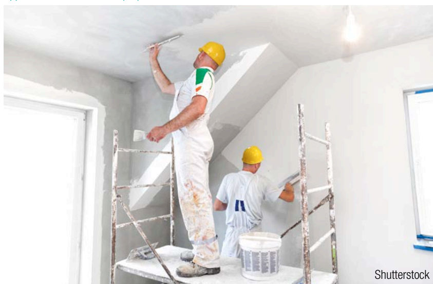
Application d'un enduit de préparation.
