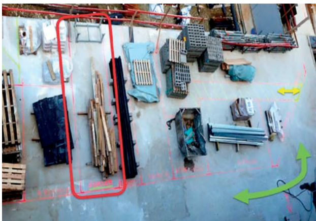
Voorbeeld van het gebruik van visueel management en de 5S-methode om de opslagzone op de werf beter te organiseren. De circulatiezones worden aangeduid door de pijlen.
