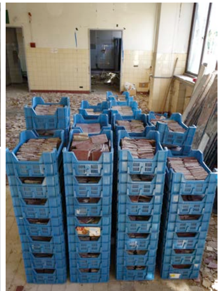
5 | Selectieve ontmanteling en voorbereiding voor hergebruik (bron: Rotor, CFE Brabant & WTCB).
